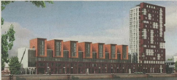
De bouw van De Pionier langs het Spaarne is van start gegaan.
